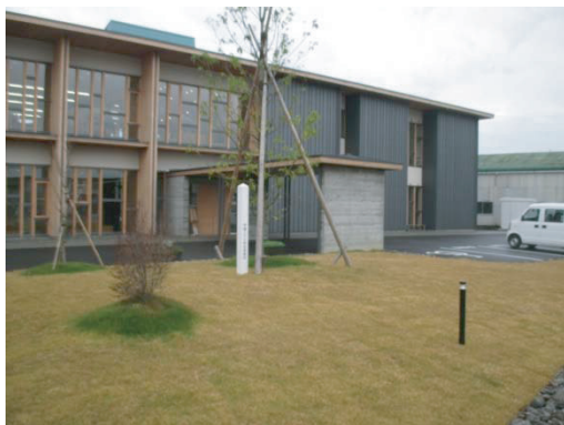
先進地高知県森林組合連連合会会館外観
