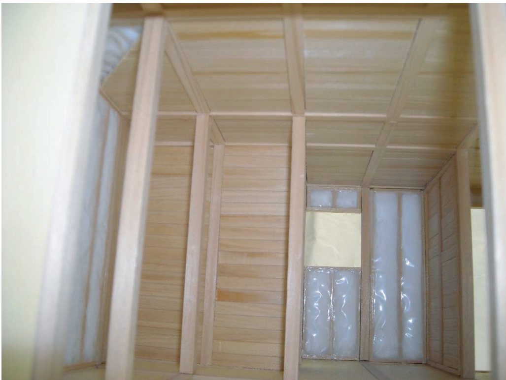
軸組模型（パネルの構成：天井・落とし込み壁）
