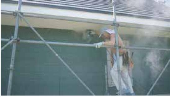
写真3 通気層上部の外装材カット
