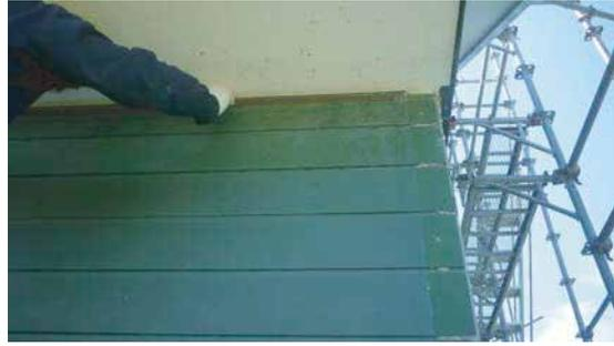
写真4 塩ビ板の挿入による通気層閉鎖
